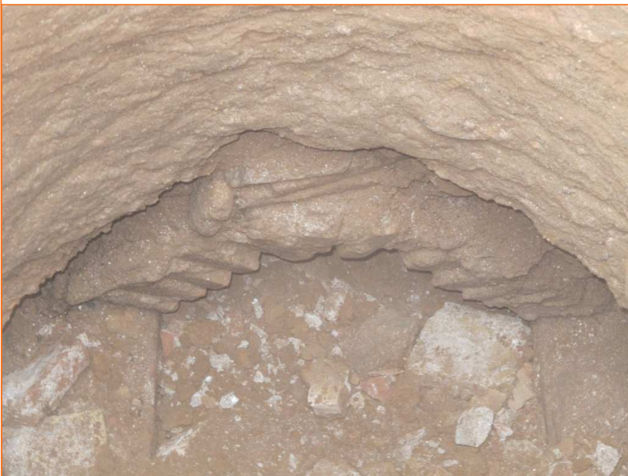
Foto 8. Detall de la volta obrada (UE 20) de la mina d'aigua al seu pas pel pou de registre. UA 2.
