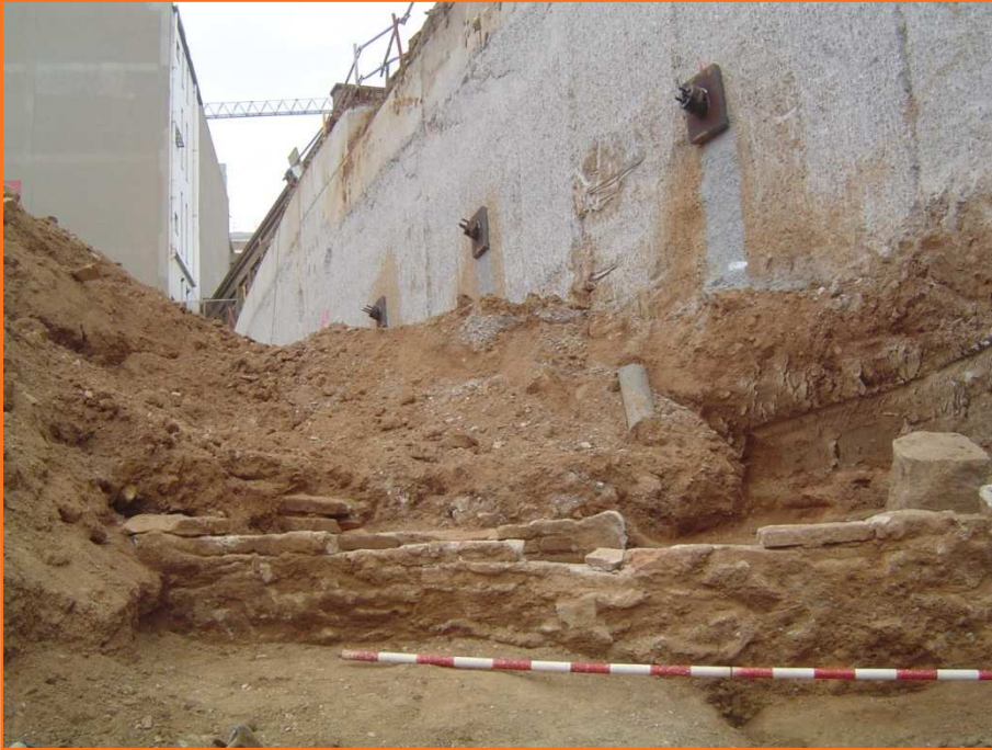
Foto 9. Vista del mur sud (UE 16), de la mina d'aigua UA 2, en el seu tram est, abans de procedir al seu desmuntatge.
