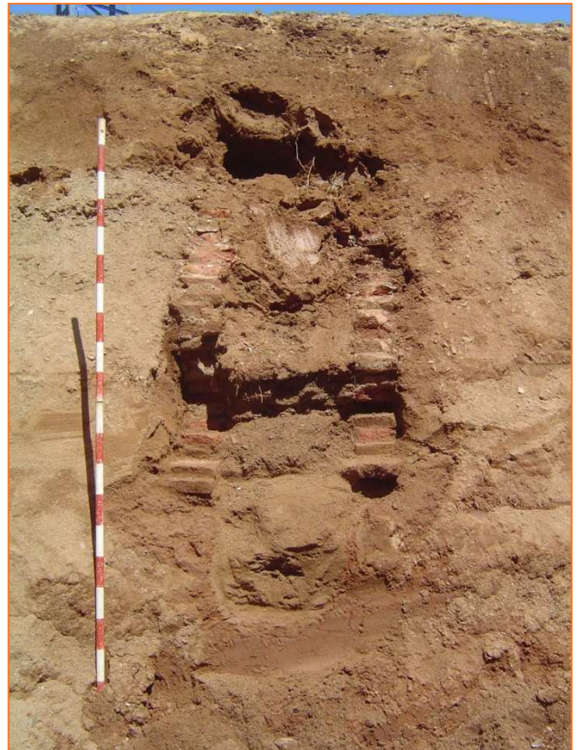
Foto 10. Vista en secció de la mina d'aigua UA 2, amb la seva volta cedida. S'hi poden observar els nivells UE 3, 19 i 21, perforats per la mina. Tram est.
